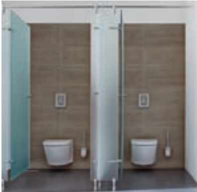
Hurtigt: installation på række Skillevægsinstallation foran mur
